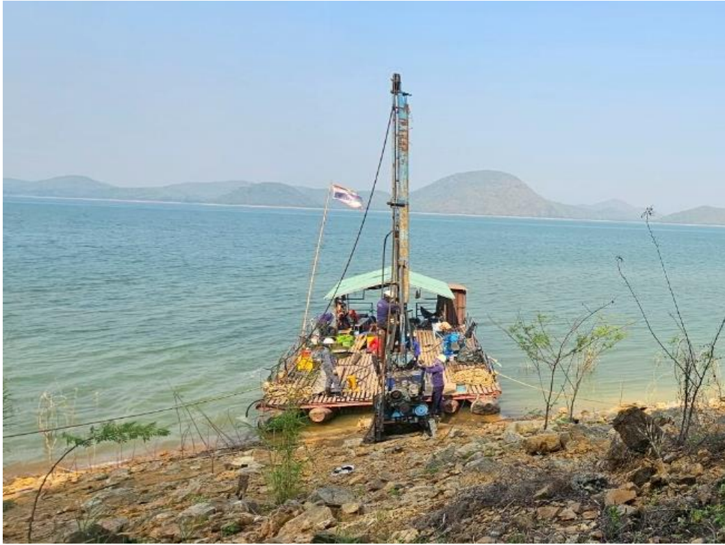
รูปที่ ก-12 การเจาะสำรวจชั้นดินและหิน บริเวณหลุมเจาะ A-13
