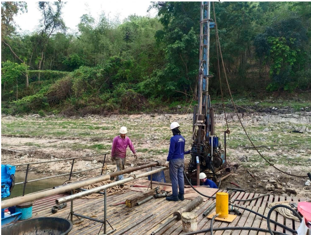
รูปที่ ก-9 การเจาะสำรวจชั้นดินและหิน บริเวณหลุมเจาะ A-10
