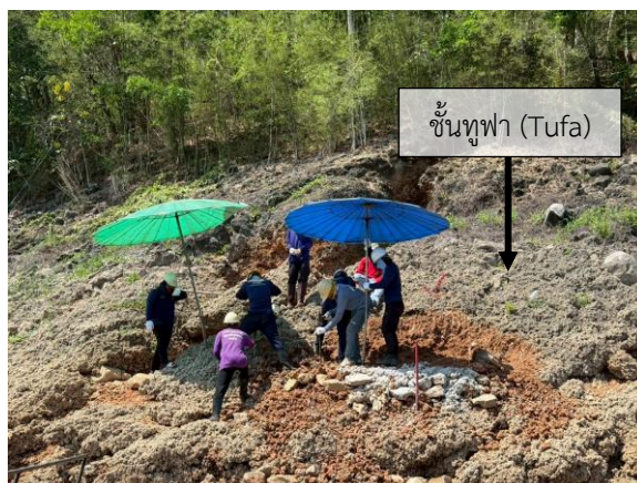
รูปที่ 6 พื้นที่ที่มีชั้นตะกอนตุนาปกคลุม จำเป็นต้องปรับพื้นที่โดยการใช้เครื่องสกัด (Jack Hammer)
