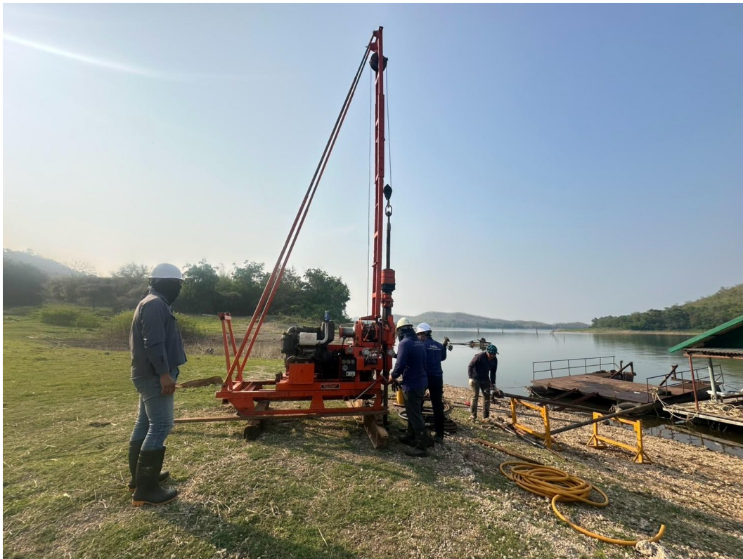
รูปที่ ก-3 การเจาะสำรวจชั้นดินและหิน บริเวณหลุมเจาะ A-4
