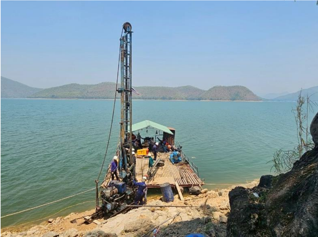
รูปที่ ก-28 การเจาะสำรวจชั้นดินและหิน บริเวณหลุมเจาะ A-28
