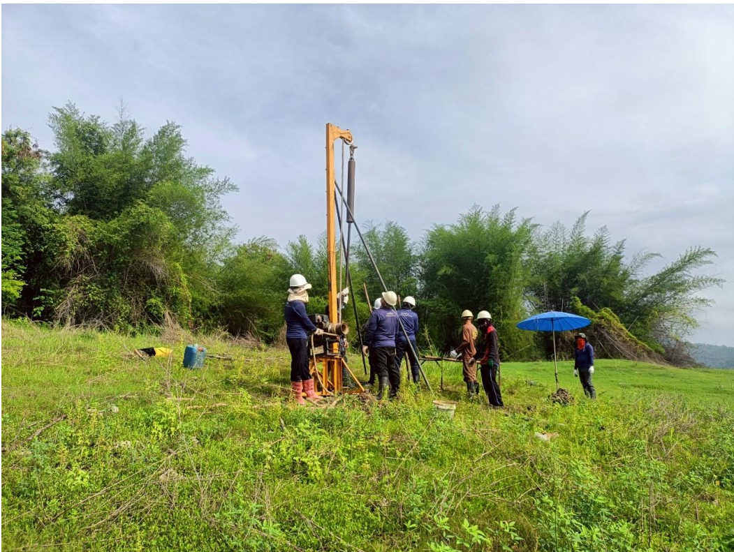
รูปที่ ก-41 การเจาะสำรวจชั้นดินและหิน บริเวณหลุมเจาะ A-41
