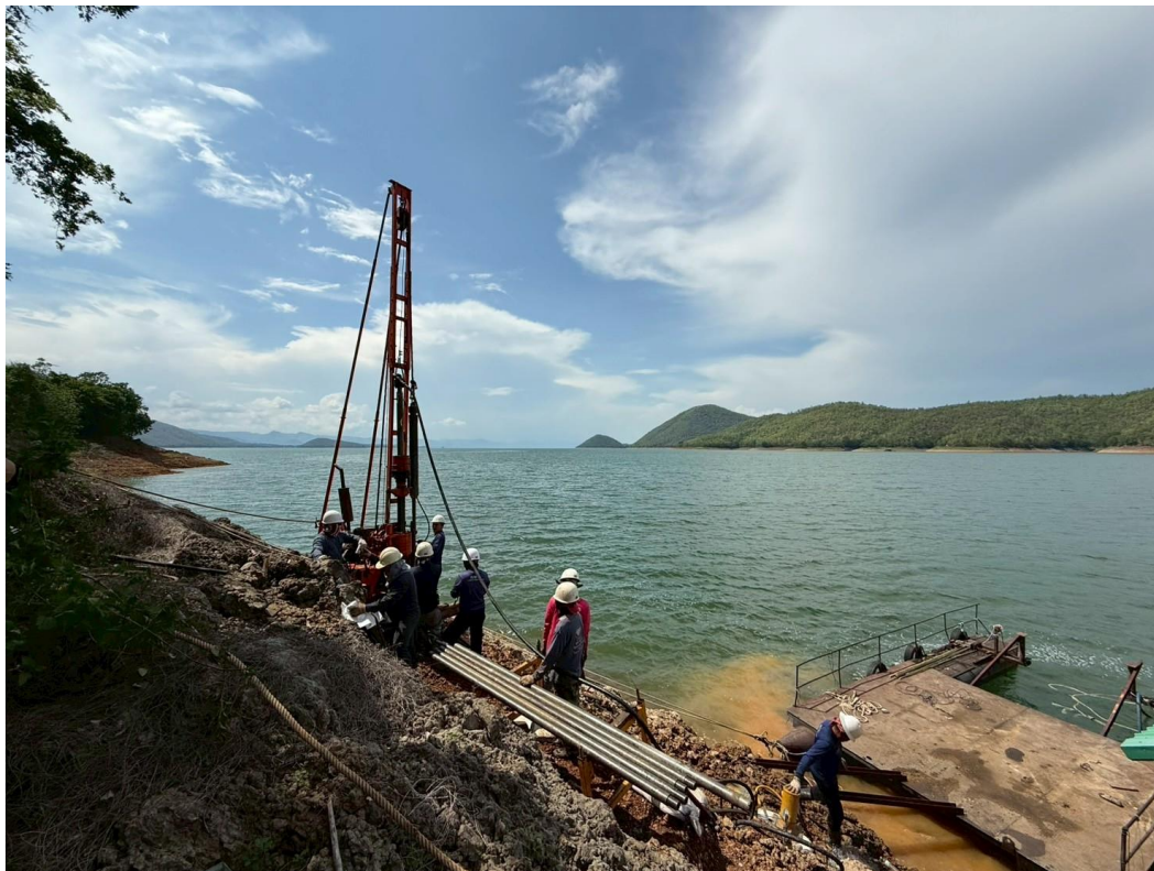
รูปที่ ก-33 การเจาะสำรวจชั้นดินและหิน บริเวณหลุมเจาะ A-33
