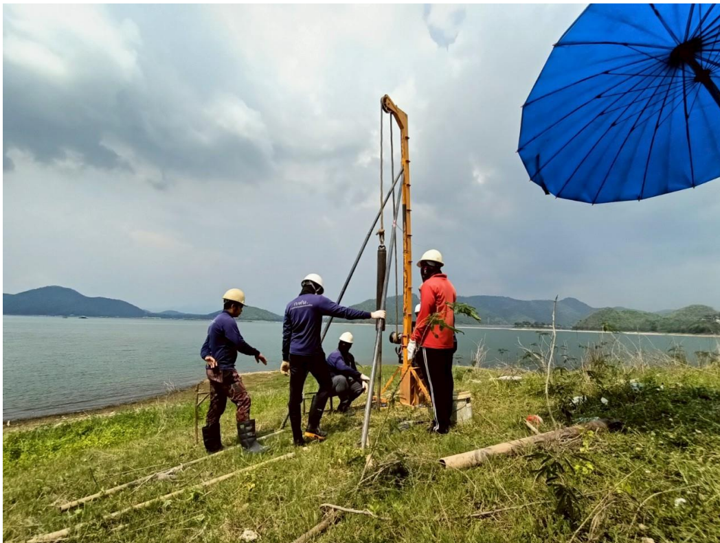
รูปที่ ก-39 การเจาะสำรวจชั้นดินและหิน บริเวณหลุมเจาะ A-39
