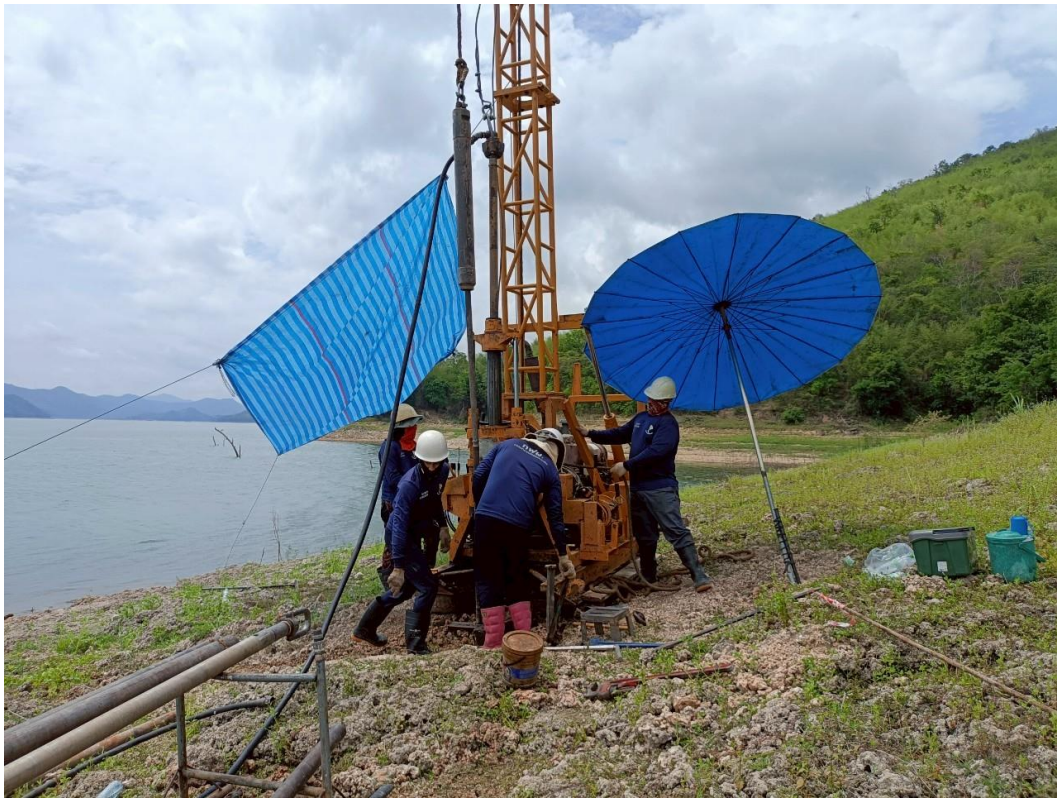
รูปที่ ก-10 การเจาะสำรวจชั้นดินและหิน บริเวณหลุมเจาะ A-11
