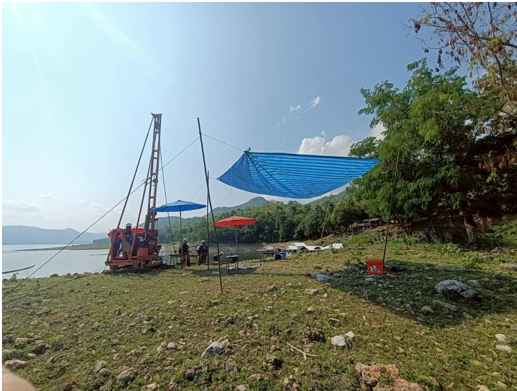
รูปที่ ก-24 การเจาะสำรวจชั้นดินและหิน บริเวณหลุมเจาะ A-25
