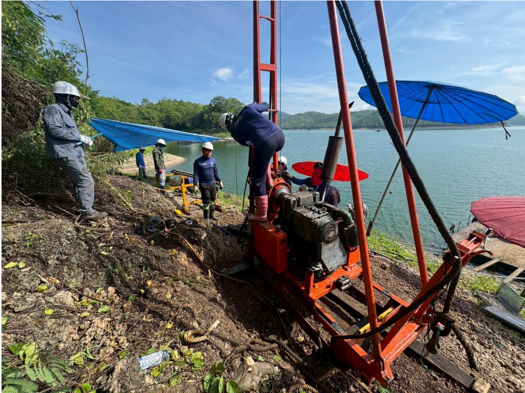
รูปที่ ก-36 การเจาะสำรวจชั้นดินและหิน บริเวณหลุมเจาะ A-36
