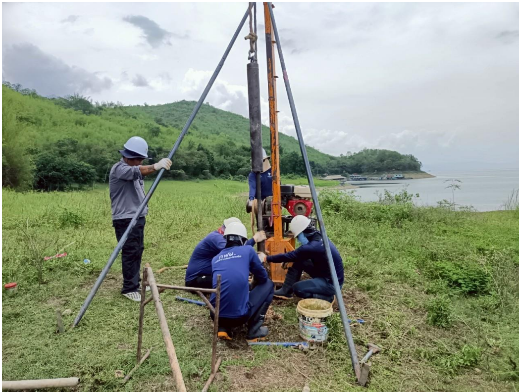
รูปที่ ก-38 การเจาะสำรวจชั้นดินและหิน บริเวณหลุมเจาะ A-38
