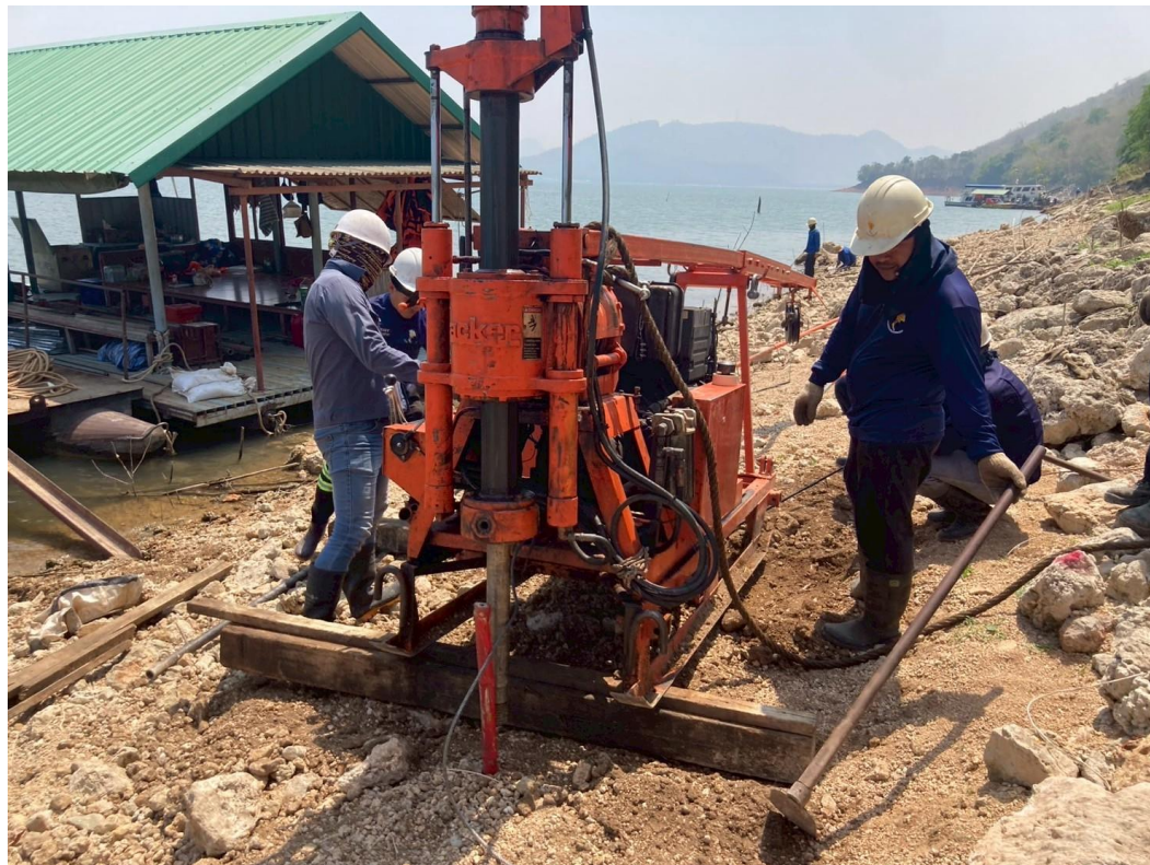
รูปที่ ก-27 การเจาะสำรวจชั้นดินและหิน บริเวณหลุมเจาะ A-27
