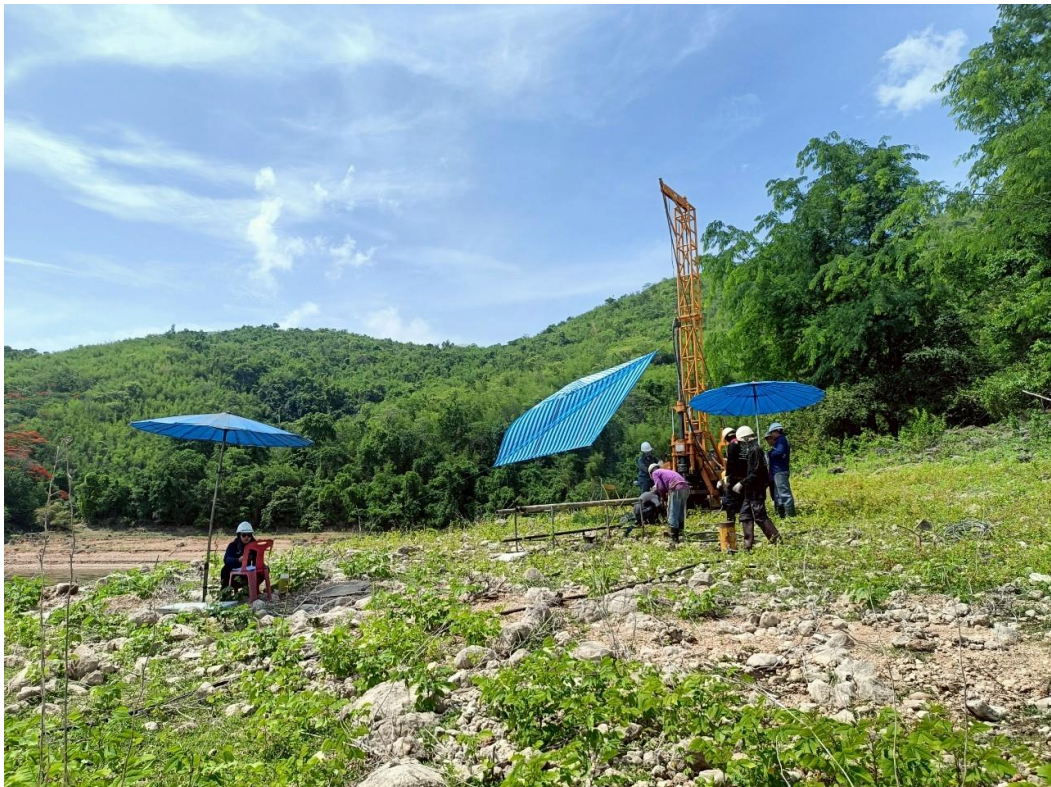
รูปที่ ก-19 การเจาะสำรวจชั้นดินและหิน บริเวณหลุมเจาะ A-19
