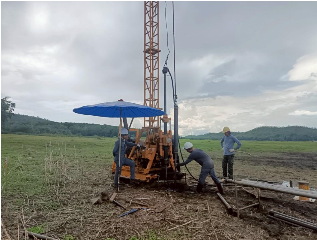
รูปที่ ก-2 การเจาะสำรวจชั้นดินและหิน บริเวณหลุมเจาะ A-3
