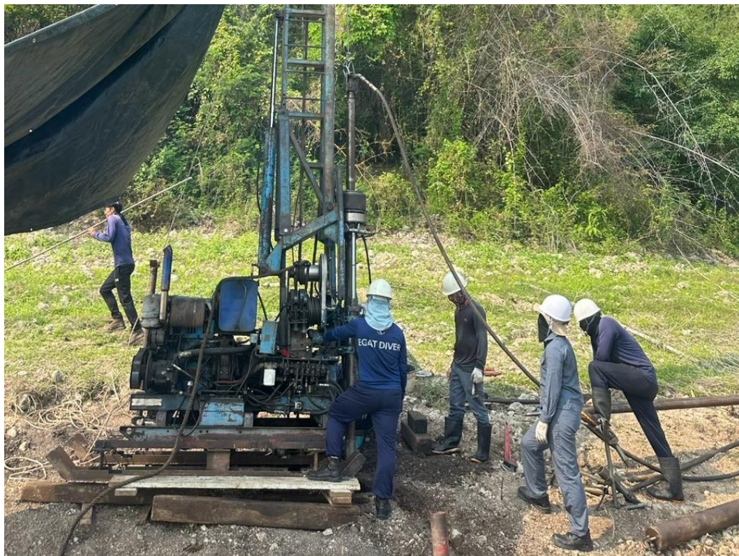
รูปที่ ก-5 การเจาะสำรวจชั้นดินและหิน บริเวณหลุมเจาะ A-6
