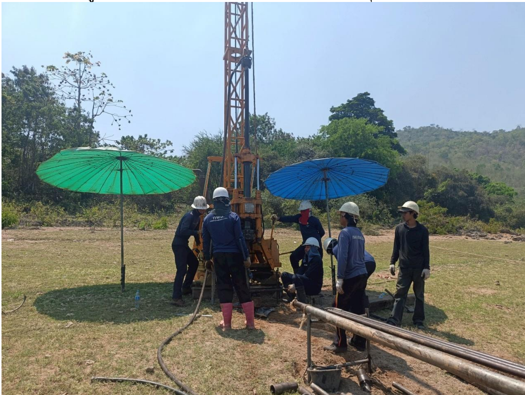
รูปที่ ก-15 การเจาะสำรวจชั้นดินและหิน บริเวณหลุมเจาะ A-16
