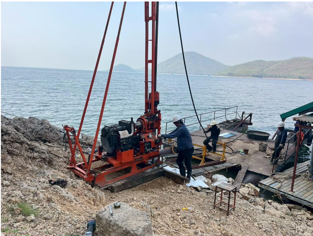
รูปที่ ก-29 การเจาะสำรวจชั้นดินและหิน บริเวณหลุมเจาะ A-29
