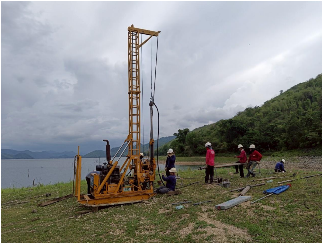
รูปที่ ก-4 การเจาะสำรวจชั้นดินและหิน บริเวณหลุมเจาะ A-5
