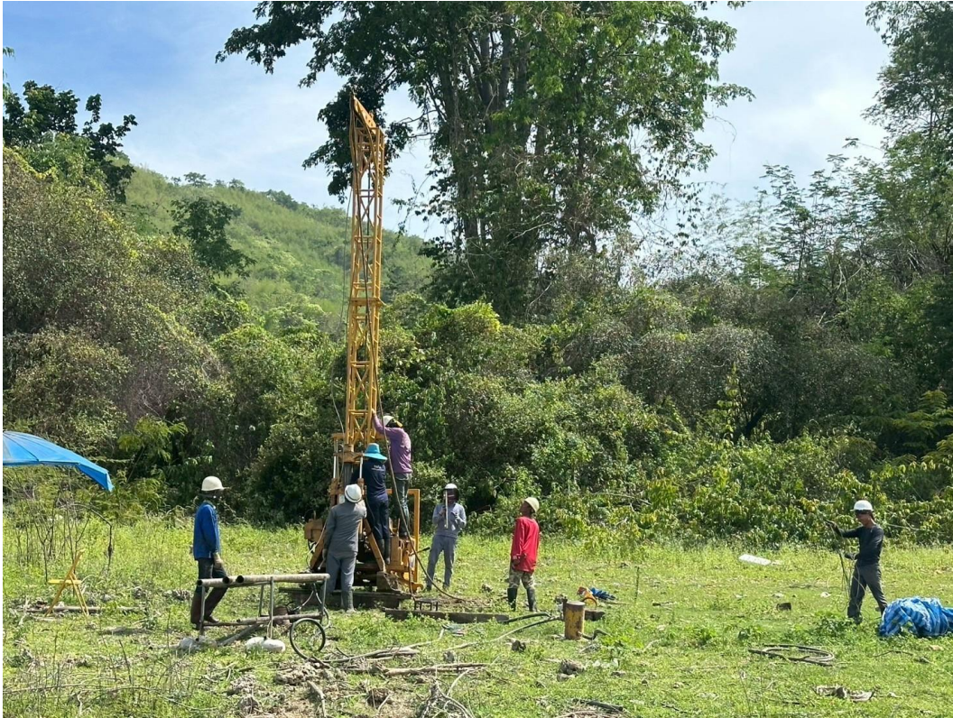
รูปที่ ก-14 การเจาะสำรวจชั้นดินและหิน บริเวณหลุมเจาะ A-15
