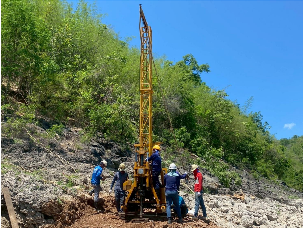
รูปที่ ก-30 การเจาะสำรวจชั้นดินและหิน บริเวณหลุมเจาะ A-30
