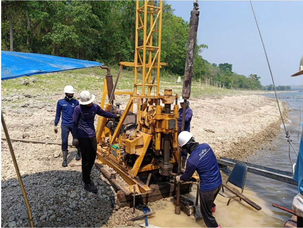
รูปที่ ก-8 การเจาะสำรวจชั้นดินและหิน บริเวณหลุมเจาะ A-9
